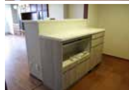
キッチンの背面にカップボードを設置し、リビング側から見えないように壁を造作。
